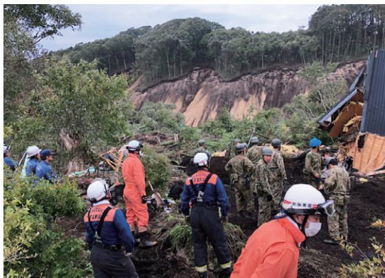
胆振東部消防組合消防本部の活動状況 (胆振東部消防組合消防本部提供)
