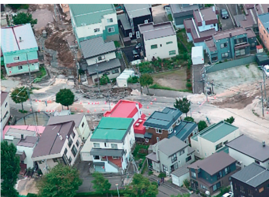
札幌市液状化現象の被害状況① (札幌市消防局提供)
